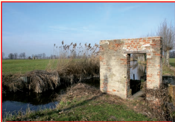
Lungo il suo percorso il fiume Tormo alimenta numerose rogge da esso derivate attraverso dei manufatti di regolazione.
