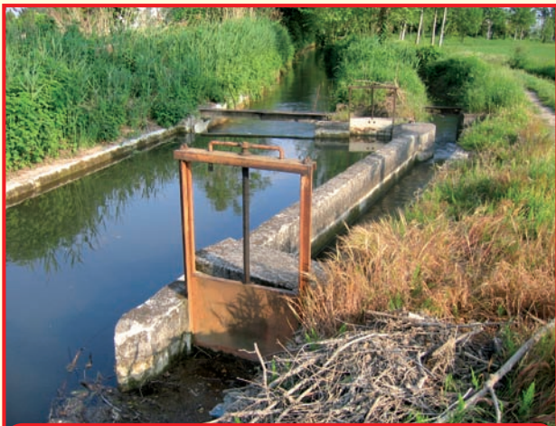
Dai canali principali si diramano distributrici irrigue via via minori, comunemente dette rogge o seriole attraverso prese di derivazione. Queste sono dotate, nella gran parte dei casi, di paratoie, oggi per lo più in metallo, a scorrimento verticale tra due binari, detti gargàmi, al fine di regolare la quantità d'acqua derivata. Le manovre di regolazione possono avvenire manualmente, soprattutto per paratoie piccole o di antica data, oppure a mezzo di motori. Dopo la bocca esiste, normalmente, il misuratore della portata transitante.
